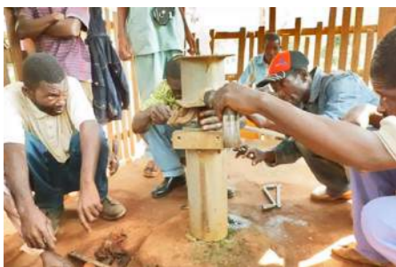
Riparazione di una pompa per l'acqua a Mbaiki nell'ambito del progetto finanziato da Unicef
